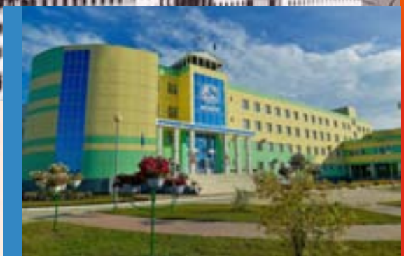
Современное здание Арктического ГАТУ
